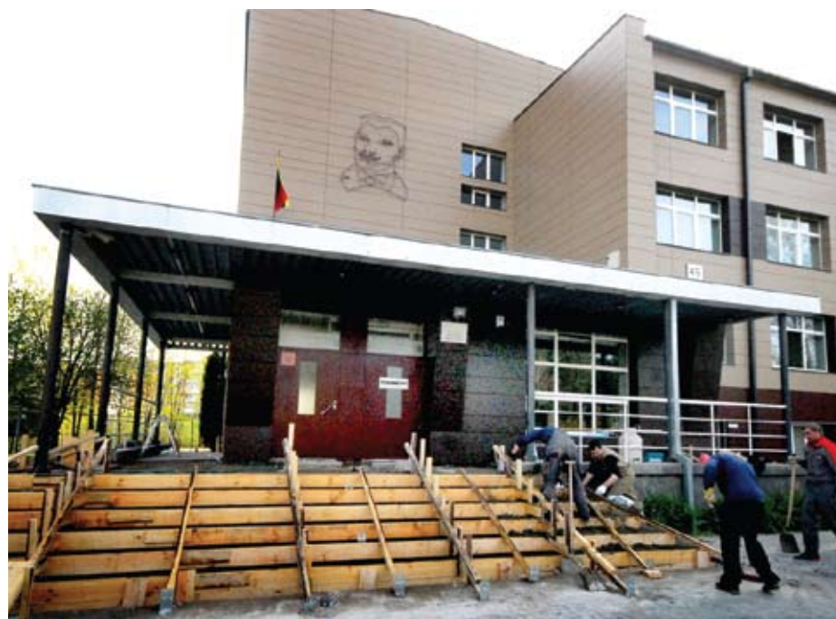
Ilgai trukusi Jono Biliūno gimnazijos pastato rekonstrukcija darbus atlikusiai UAB „Anrestui“ gali brangiai kainuoti.
